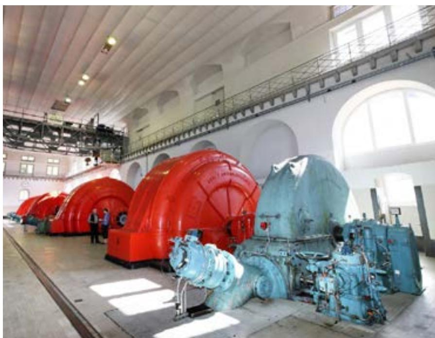
**“... Das Gefälle zwischen dem Ritomer See auf 1847 Meter über dem Meeresspiegel und Piotta nutzend (mit einer Fallhöhe von 850 Metern) leitet eine neue Leitung das Wasser in die Ebene und zwei moderne Turbinen mit einer Leistung von 60 MW speisen, die mehr als 160 Gigawatt Energie pro Jahr ...”**
